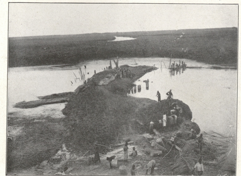
CONSTRUCTION DE LA DIGUE DE KISANGILA AU LAC KISALE AU FOND LE LUALABA NAVIGABLE AU MILIEU DES PAPYRUS
