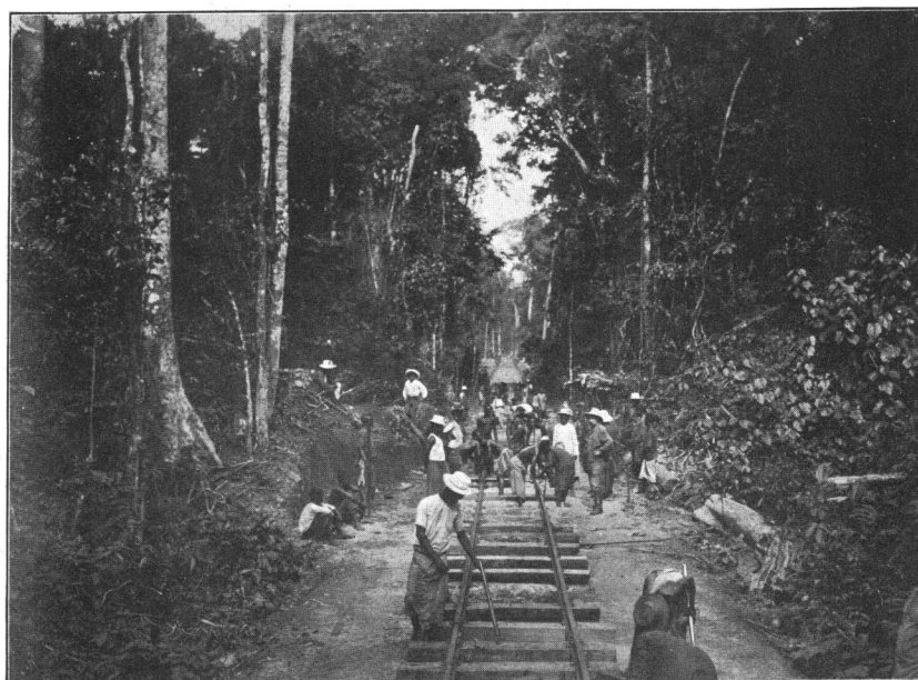
POSE DE LA VOIE AU KILOMÈTRE 70
