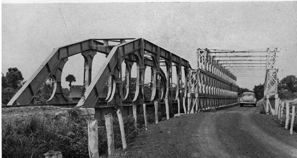
B.C.K. — Pont rail-route à Malonga-Katanga.
