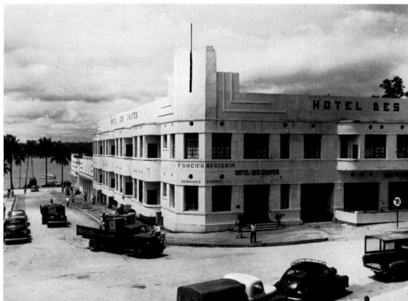
Province Orientale – Stanleyville. – L'hôtel des chutes.
