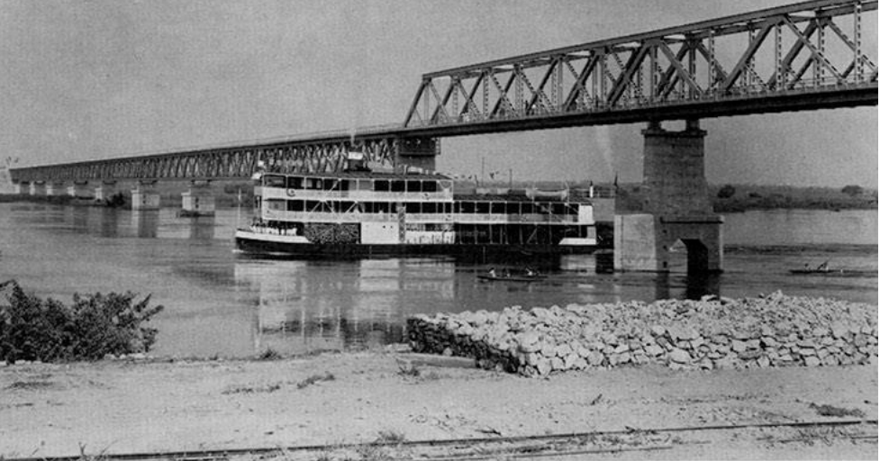
C.F.L. — Le grand pont rail-route enjambant le Lualaba à Zofu.
