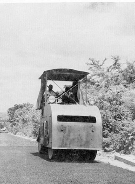
Asphaltage de la route Léopoldville-Matadi.
