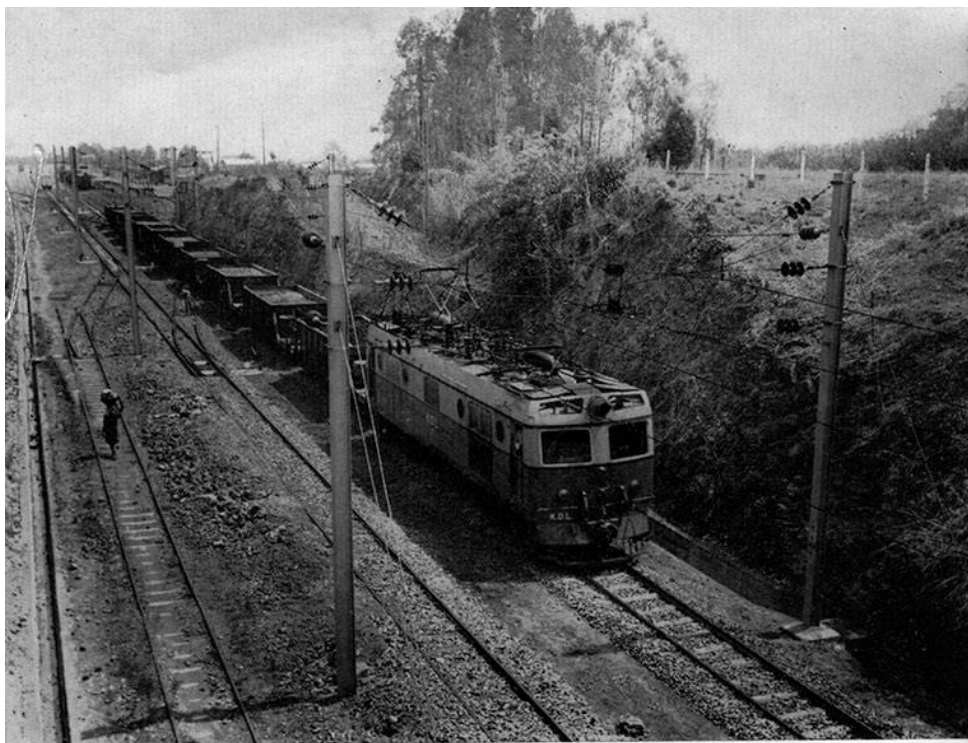
B.C.K. — Convoi sur la ligne électrifiée Jadotville-Tenke.
