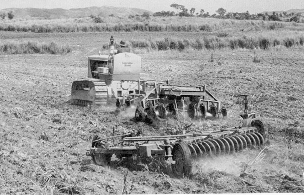
Bas-Congo. — Luozi. — Travaux de motoculture en milieu rural.
